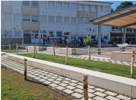
▲ Travail sur les revêtements de sol et éléments de mobilier en béton coulé sur place
