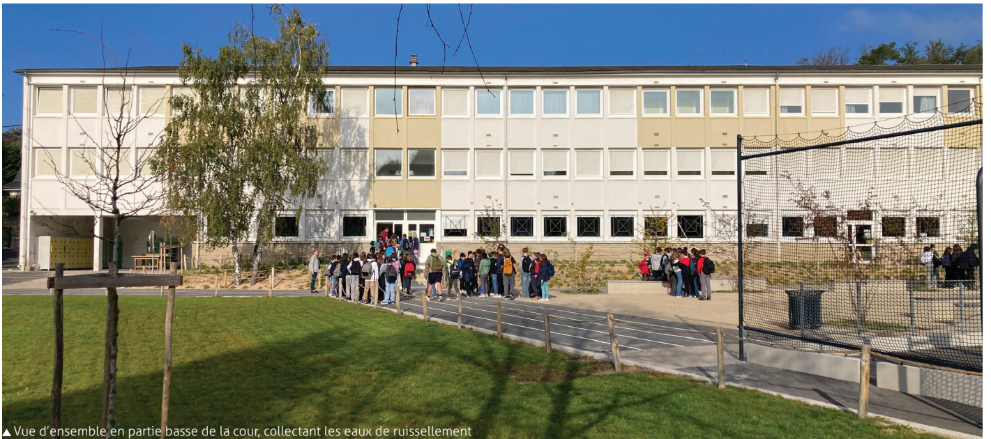
▲ Vue d'ensemble en partie basse de la cour, collectant les eaux de ruissellement
