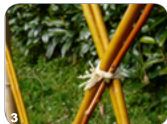
Réalisation d'une fascine de Saule vivant (Pays Ouest Creuse)
