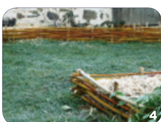
Réalisation d'une bordure plessée (Pays Ouest Creuse)
