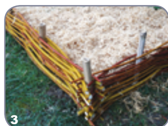
Réalisation d'une bordure plessée (Pays Ouest Creuse)
